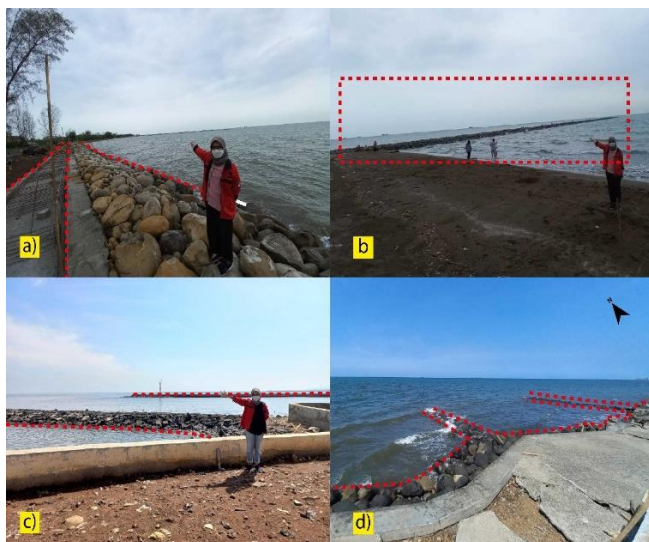
Gambar 10. Jenis perlindungan pantai di Kota Pekalongan a) Revetment (X,Y= 356490, 9241321); b) Pemecah gelombang (X,Y= 356151, 9241440); c) Jetty (X,Y= 355505, 9241883); d) Groyne (X,Y= 354378, 9241703).
