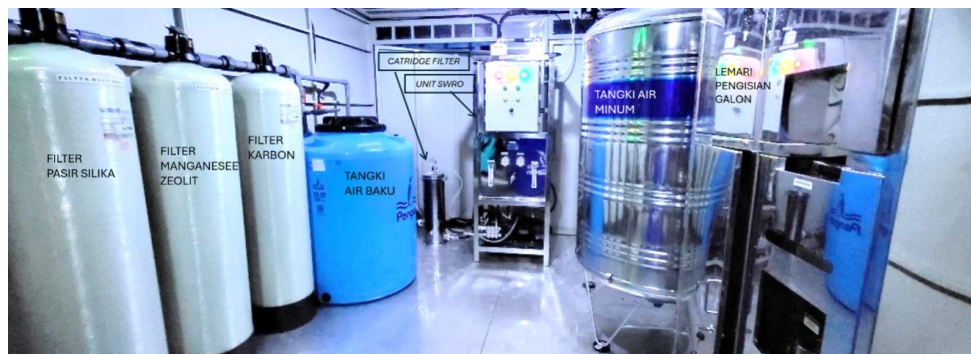
Gambar 4. Peralatan sistem SWRO yang digunakan dalam penelitian
