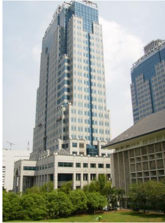
Gambar 2. Dinding Luar Gedung BI Dengan Sistem Pengangkur Digunakan Lj-Angkur 8)
