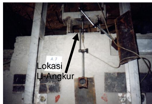
Gambar 1. \perp -Angkur Terpasang Pada Tepi Lantai Beton Gedung BI (1996) 8)
