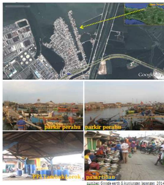
Gambar 10. Kondisi PP Tambaklorok – Semarang
