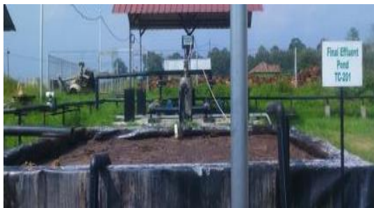
Gambar 4. Akumulasi cake pada permukaan final effluent pond
