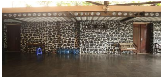
Gambar 8. Bagian Dinding Gereja Santo Yoseph Matraman yang Dilapisi Susunan Batu Kali. (Gambar: Bestari, 2022)
