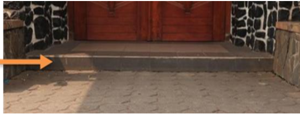
Gambar 7. Fondasi pada bangunan utama Gereja Santo Yoseph Matraman (Sumber: Bestari, 2022)
