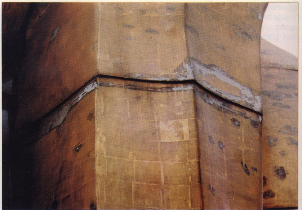
Foto 4 Pengelupasan Lapisan Emas pada Badan Lidah Api Monas
