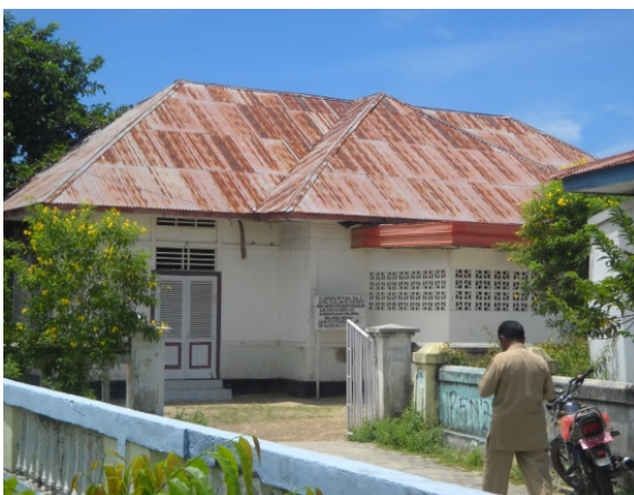
Foto 15. Bangunan bekas kantor pemerintah Belanda di Namlea (Sumber: Dokumen Balar Ambon, 2011 ).
