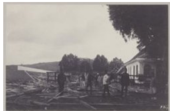
Foto 1. Kerusakan pada bagian dalam Benteng Nieuw Victoria setelah gempa tahun 1898 di Ambon (Sumber: www.kitlv.nl ).
