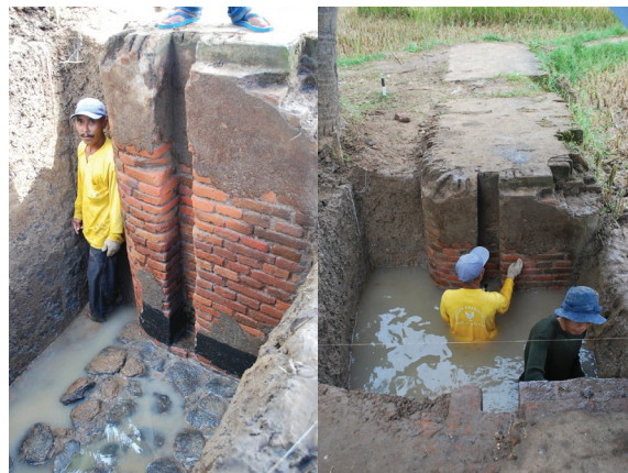
Foto 3. Struktur Bendungan Endol.
