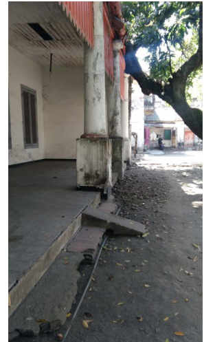
Foto 16. Samping Bangunan Kantor Pos Gresik (Sumber: Putranto)
