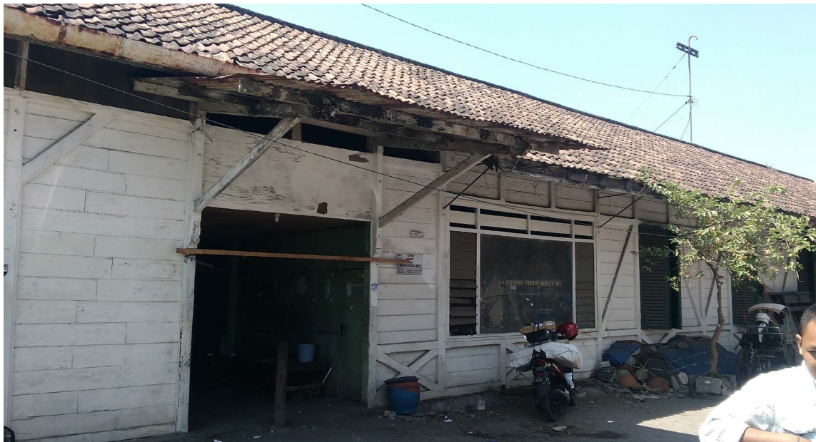
Foto 17. Fasad Stasiun Lama Gresik (Sumber: Putranto)
