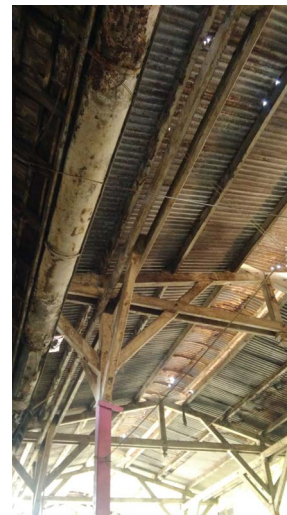
Foto 21. Atap Emplasemen Stasiun Lama Gresik (Sumber: Putranto)
