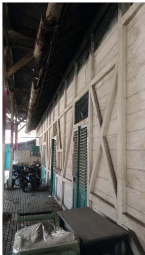
Foto 18. Bagian Belakang Bangunan Stasiun Lama Gresik (Sumber: Putranto)
