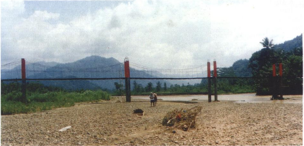
Foto-12: Tampak tim penelitian sedang melakukan pengamatan alat litik di Kali Lorog, di sekitar jembatan gantung Narohadi.
