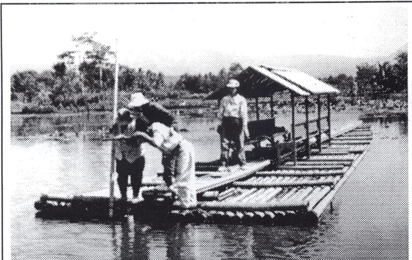
Foto 2. Pengambilan contoh tanah di tengah-tengah perairan Danau Canguang dengan sistem Boring.
