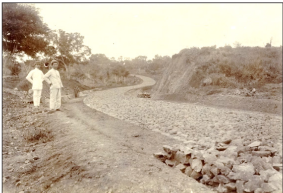
Gambar 3. Proses Pembangunan jalan area Candi Baru (Sumber: Digital Collection Leiden University, diakses pada Maret 2023)
