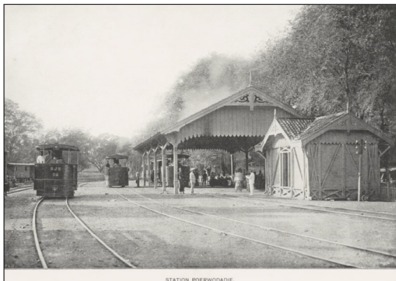
Gambar 8. Stasiun Purwodadi dengan kanopi kayunya (1907)
