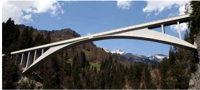
Gambar 2. Salginatobel Bridge, Switzerland (1930) Jembatan dari beton bertulang dengan lebar 3,5 m, panjang 132,3 m dan bentangan 90 m. (Sumber: britannica.com )
