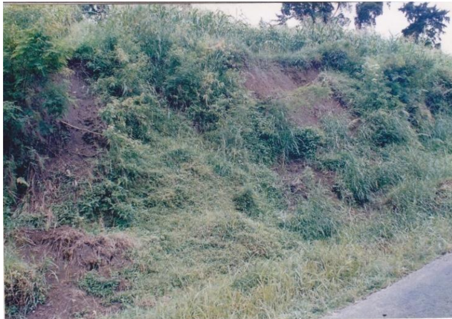
Gambar 6. Kenampakan lereng Utara yang mengalami longsor kecil, karena kondisi tanah yang labil (Dok. Penulis)
