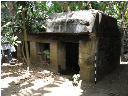
Gambar 10. Bunker KCG-14 terletak di permukiman di kawasan pantai
