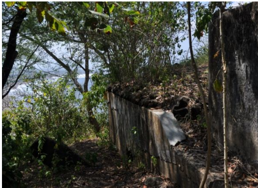
Gambar 12. Bunker WLH-01 dengan latar belakang laut selatan
