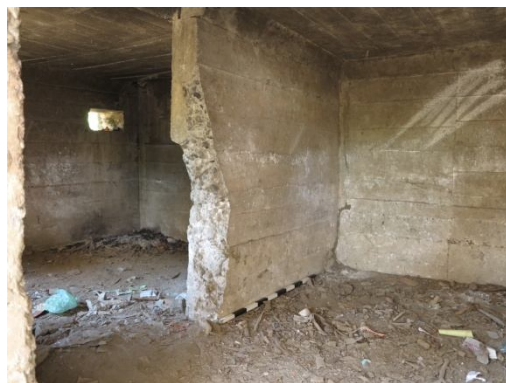
Gambar 1. Bagian dalam Bunker YWL-01
