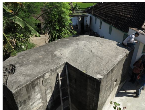
Gambar 2. Bunker YWL-08 yang berdenah seperti huruf L
