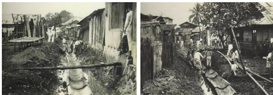
Gambar 7. Pembangunan saluran air (got) di Manado tahun 1930an. (Sumber: KITLV A313 - Aanleg van riolering in een woonwijk te Manado | Digital Collections (universiteitleiden.nl) dan KITLV A313 - Aanleg van riolering in een woonwijk te Manado | Digital Collections (universiteitleiden.nl) , diunduh tanggal 21 September 2023)
