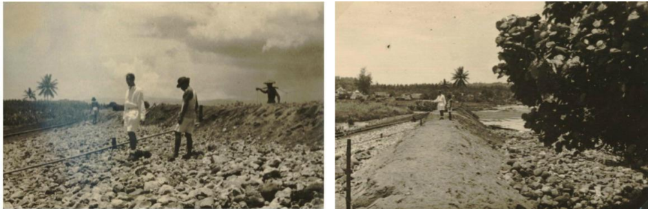
Gambar 8. Pembangunan talud Sungai Tondano.
