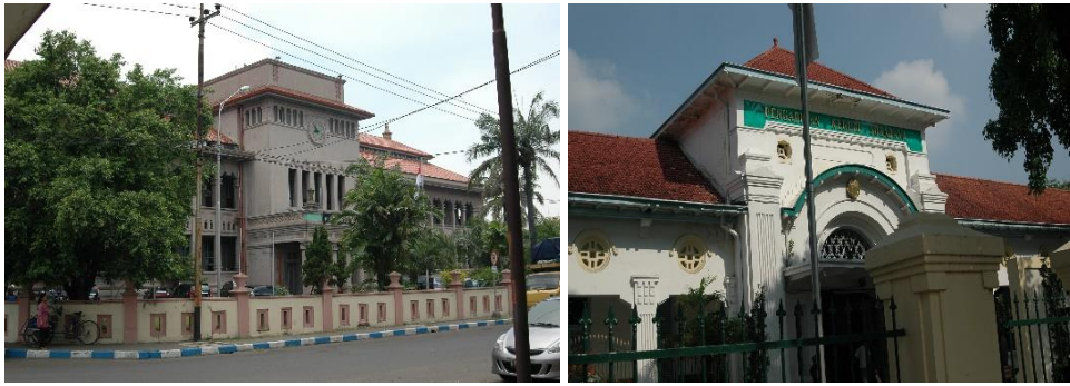
Gambar 7. Gedung perkantoran untuk Kantor Pusat Perkebunan Nusanantara XI (Persero) di Jl. Merak No. 1 (kiri), dan Kantor Pengadilan Negeri Surabaya di Jl. Arjuna No. 16-18 (kanan). (Sumber: Balai Arkeologi Yogyakarta, 2009)
