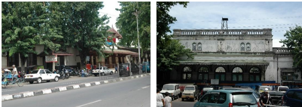
Gambar 4. Fasad depan bangunan Stasiun Semut dan Stasiun Gubeng (Sumber: Balai Arkeologi Yogyakarta, 2009)
