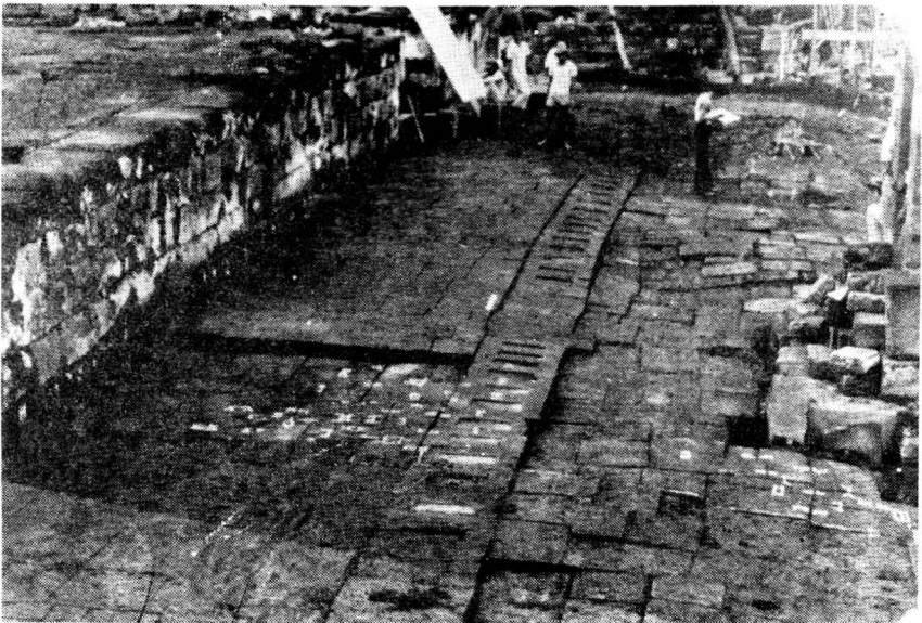
Lantai dan pagar I setelah pembongkaran batu lapis pertama di atasnya.
