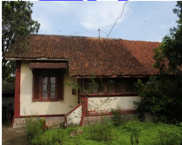
Gambar 16. Bangunan tipe F tampak depan. (Sumber: Nugroho, 2021)
