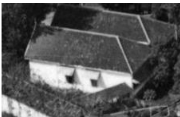
Gambar 14. Bangunan tipe D tampak atas. (Sumber: https://digitalcollections.universiteitleiden.nl/ )
