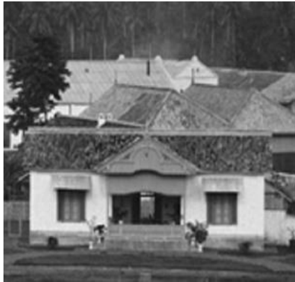
Gambar 7. Bangunan tipe B.
