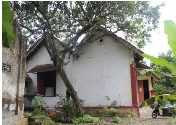
Gambar 17. Bangunan tipe F tampak samping. (Sumber: Nugroho, 2021)
