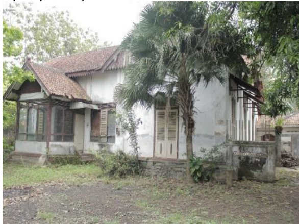
Gambar 5. Bangunan tipe A. (Sumber: Nugroho, 2021)
