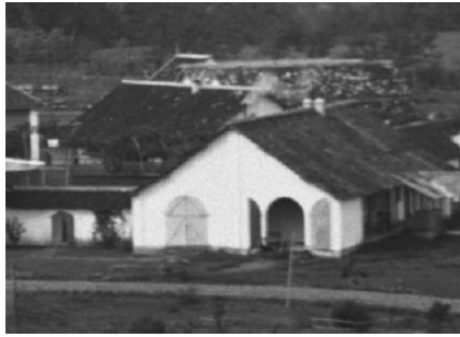
Gambar 10. Bangunan tipe C tampak depan.
