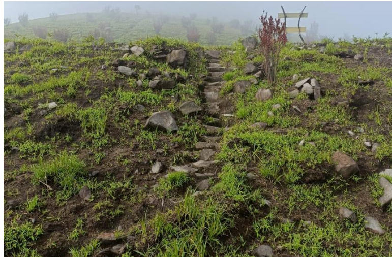
Gambar 3. Kondisi Struktur tangga batu di Teras 5 (Sumber: dokumentasi Jarwanto, 2024)
