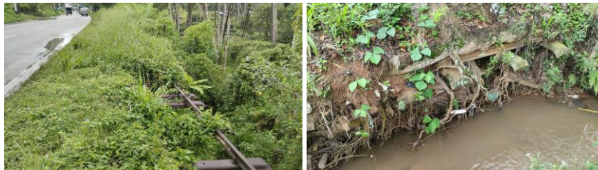
Gambar 14. Kondisi Rel Kereta Api di Afdeeling Limapuluh Kota (Sumber: Penulis, 2024)
