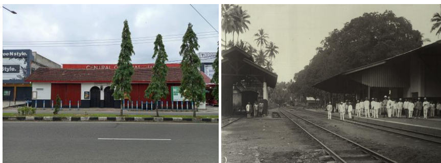
Gambar 2. Bangunan Stasiun Kereta Api Payakumbuh.
