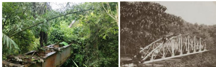
Gambar 9. Struktur Jembatan Rel Kereta Api Padang Tarok (Sumber: Penulis, 2024 & http://hdl.handle.net/1887.1/item:710995 )
