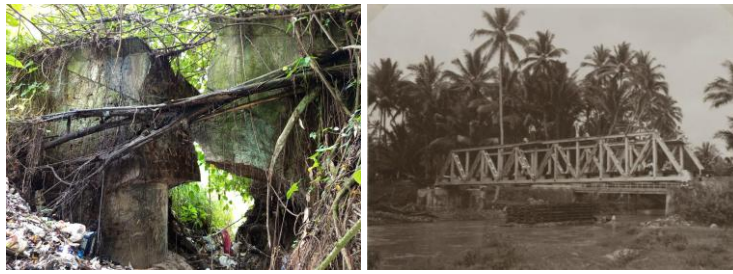
Gambar 10. Jembatan Rel Kereta Api Lampasi (Sumber: Penulis, 2024 & http://hdl.handle.net/1887.1/item:701868 )
