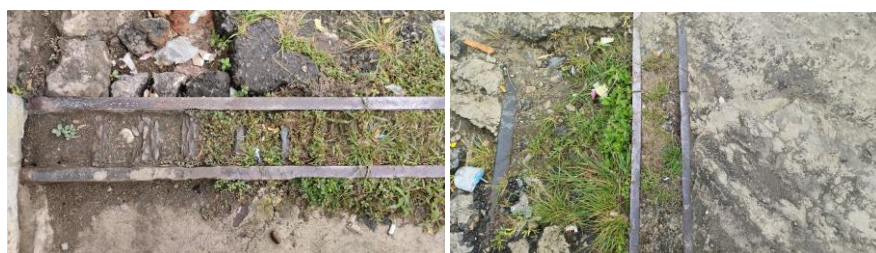
Gambar 8. Rel bergigi di Afdeeling Limapuluh Kota. (Sumber: Penulis, 2024)
