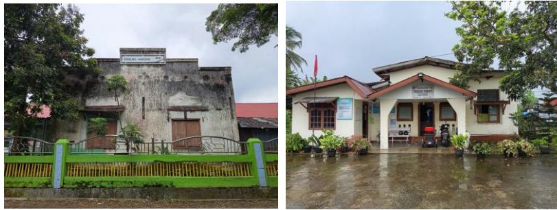
Gambar 5. Bangunan Halte Dangung-dangung (kiri) dan Eks Lokasi Bangunan Halte Simalanggang (kanan) (Sumber: Penulis, 2024)
