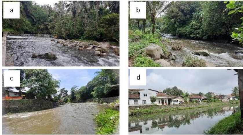
Gambar 3. Kondisi Sungai Banjaran: (a) Karangnangka, (b) Kutaliman, (c) Kober, (d) Kedungwuluh
