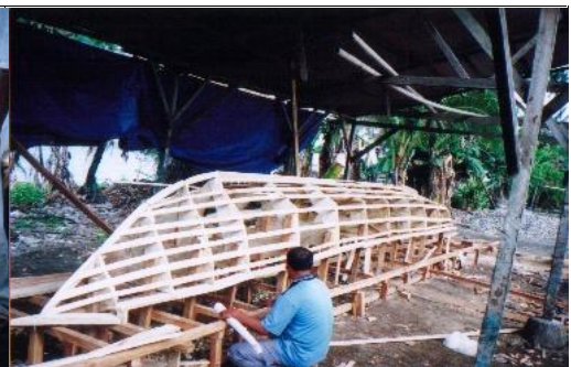
Gambar 37. Pemasangan galar & Penegar.
