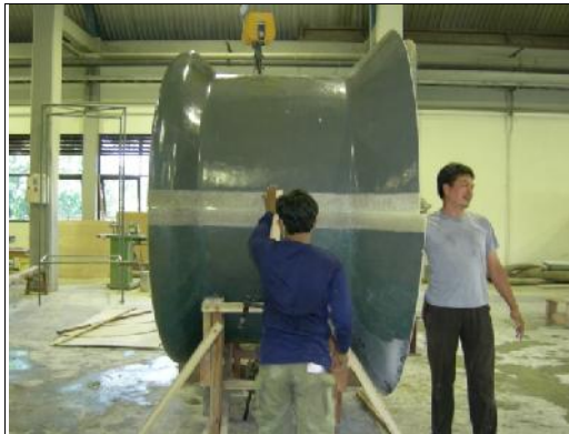
Gbr 20. Proses Penyambungan Sisi Luar.
