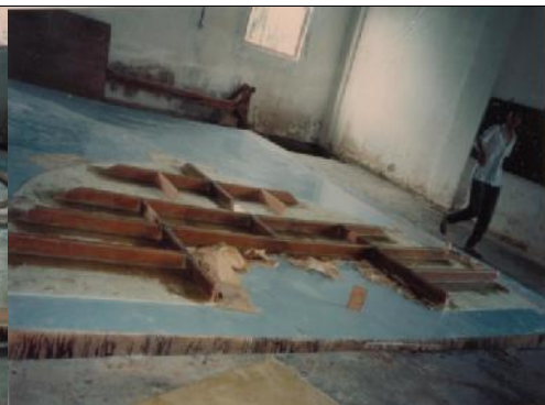
Gbr 6. Laminasi Deck Depan.
