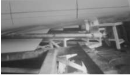
Gambar. 1 Pemasangan Strut pada poros propeller
