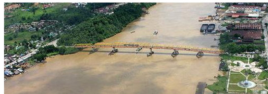
Gambar 2. Jembatan Sungai Mahakam
