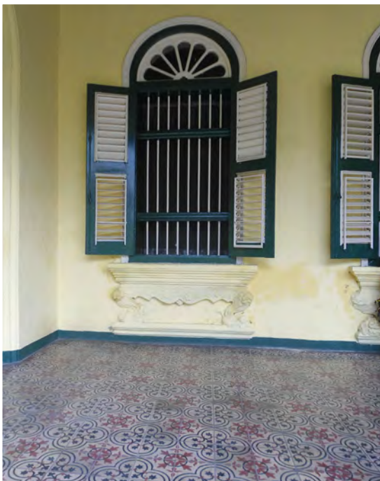
Gambar 6. Hampanan ubin enkaustik di salah satu bagian Rumah Tjong A Fie (Sumber: Sarjianto)
