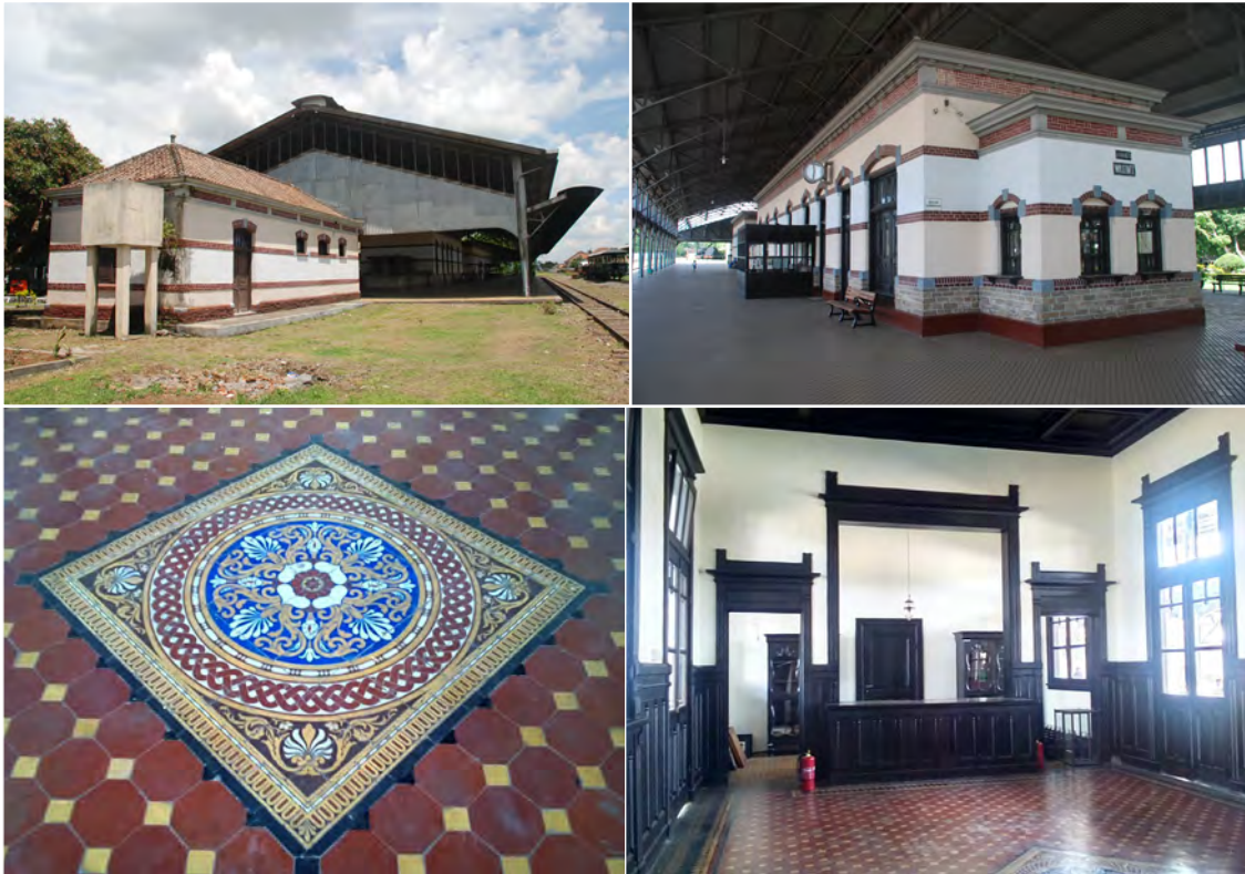
Gambar 16. (Searah jarum jam) Emplasemen Ambarawa; Bangunan ruang tunggu kelas 1 dan 2; Ubin di ruang Tunggu kelas 1 dan 2 Stasiun Ambarawa; Desain eksotis ubin enkaustik di tengah ruang tunggu kelas 1 dan 2 (Sumber: Sarjianto)
