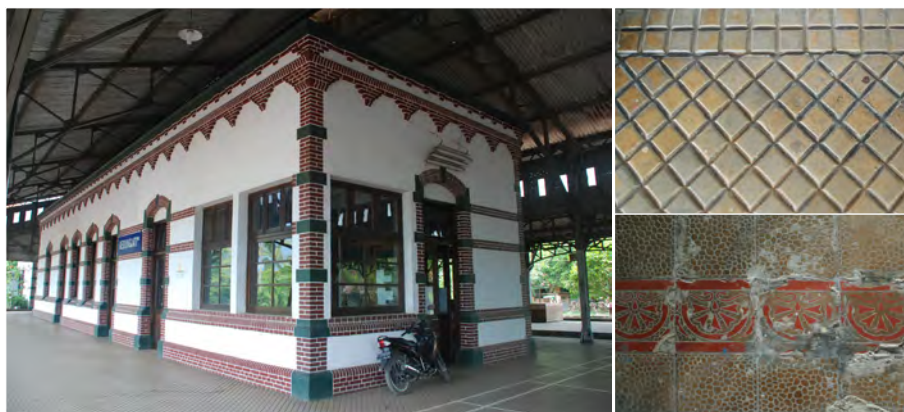
Gambar 18. (Searah jarum jam) Bangunan ruang tunggu kelas 1 dan 2; Ubin Peron dan lantai ruang tunggu kelas 3; Ubin di ruang kepala Stasiun (Sumber: Sarjianto)
