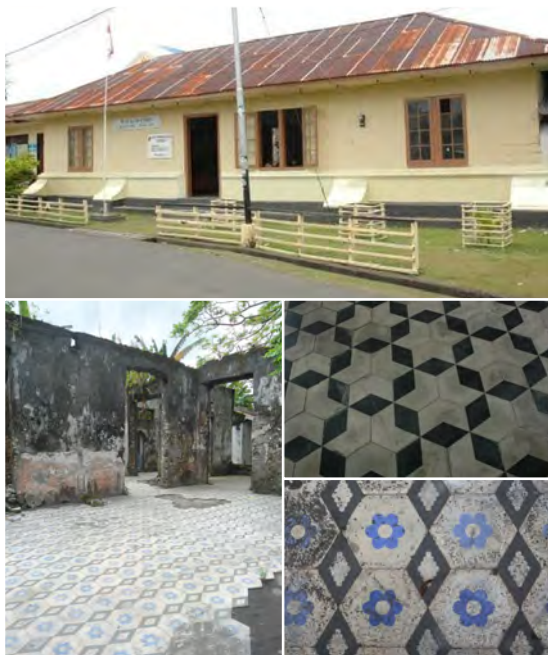
Gambar 20. (Searah jarum jam) Bangunan kantor dan gudang pala di Neira; Ubin berpola geometris di dalam bangunan kantor dan gudang pala di kota Neira; Detil hiasan ubin di salah satu bangunan yang rusak; Ubin hias berpola di salah satu bangunan yang rusak (Sumber: Sarjianto)
