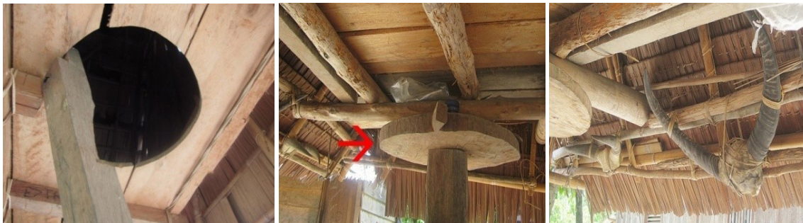
Gambar 3. Lubang untuk memasuki lumbung/loteng Buho' (kiri); cincin kayu; tanduk kerbau yang dipasang di atap sebagai dekorasi (kanan) (Sumber: Ibrahim Hane Idrus, 2012)
