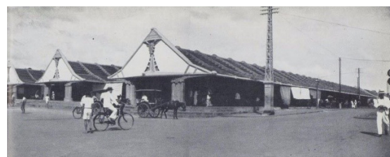
Gambar 3. Pasar Tanah Abang tahun 1930 (Sudah tidak ada pada masa sekarang) (Sumber: Verslag Van Den Toestand Der Gementee Batavia over 1912 )
