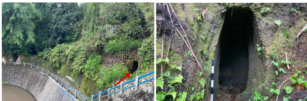
Gambar 2. Kontruksi aungan di Dam Pejeng (Sumber: Dokumen Kamandalu, 2023)
