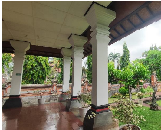
Gambar 6. Pilar/kolom pada bangunan Museum Semarajaya (Sumber: Dokumen Apsari, 2023).
