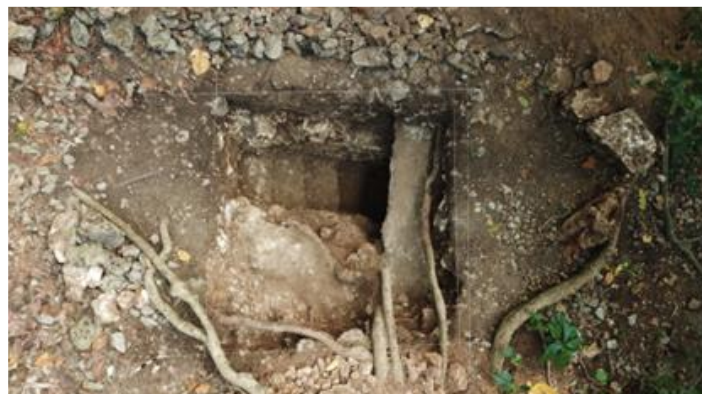
Gambar 6. Tampak atas pintu masuk Bunker 5 BCA, Pangandaran. Terlihat tangga masuk yang dibuat langsung pada karang dan atap terbuat dari beton cor bertulang (Sumber: Balai Arkeologi Jawa Barat, 2019).
