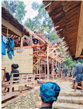
Gambar 2 Laki-laki Kanekes Bergotong Royong Membangun Rumah (Sumber: Dokumentasi Firdaus 14 Juni 2024)
